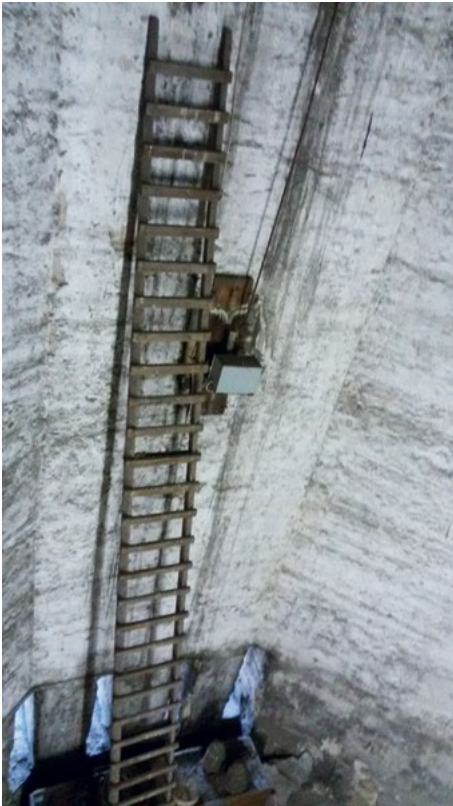
Turmhalle & neueres E-Uhrwerk
